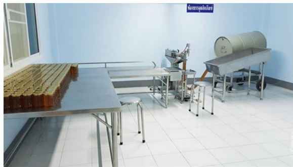
รูปที่ 6 การติดตั้งอุปกรณ์สนับสนุนในกระบวนการบรรจุน้ำผึ้งให้สามารถทำงานได้รวดเร็วและสอดคล้องตามหลักเกณฑ์มาตรฐาน GMP Codex
