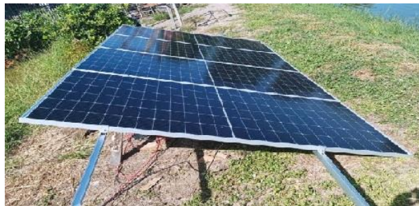
รูปที่ 2 เซลล์แสงอาทิตย์พิกัด 4320W, 384V, 13.27A
