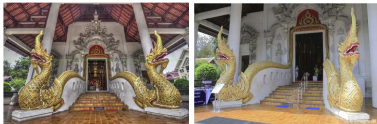
ภาพที่ 1 บันไดนาคก่อนปรับปรุง กับหลังมีการปรับปรุง มือจับ, ราวบันได ตามแบบอารยสถาปัตย์ วัดเจดีย์หลวงวรวิหาร จ.เชียงใหม่
