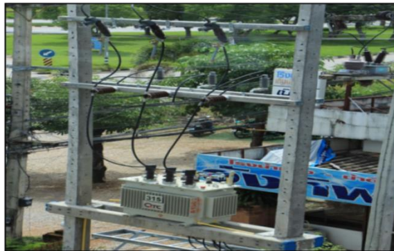
ภาพที่ 5 การติดตั้งเครื่องแปลงกระแสไฟฟ้าและตู้ควบคุมระบบไฟฟ้า
