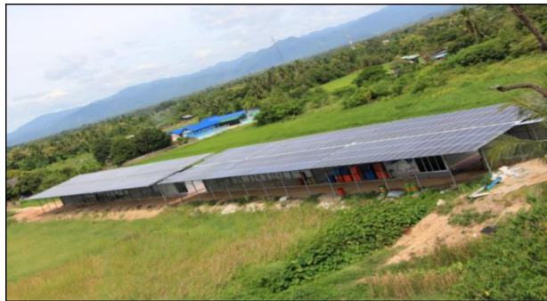
ภาพที่ 3 การติดตั้งแผงโซลาร์เซลล์บนหลังคา
