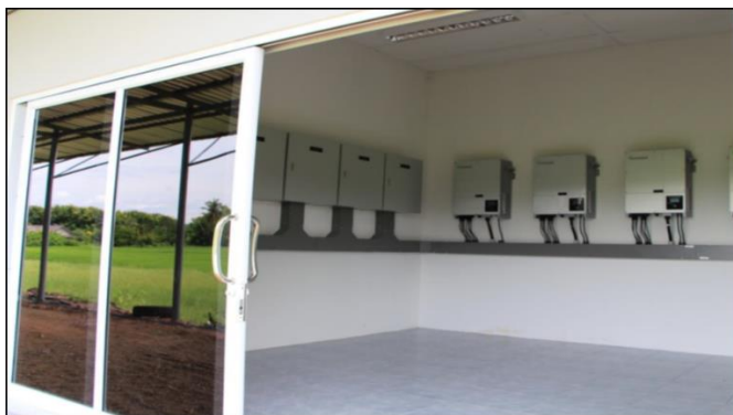
ภาพที่ 4 การติดตั้งเครื่องแปลงกระแสไฟฟ้าและตู้ควบคุมระบบไฟฟ้า
