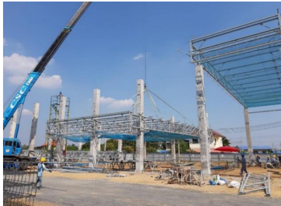
ภาพที่ 4 แสดงขั้นตอนการยกติดตั้งโครงถักหลังคาแบบกลุ่ม
