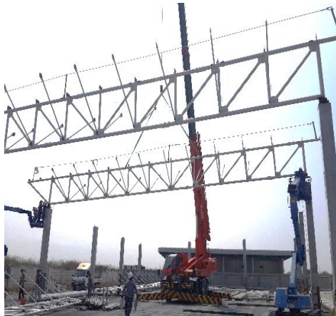
ภาพที่ 3 แสดงขั้นตอนการยกติดตั้งโครงถักหลังคา (ก่อนปรับปรุงขั้นตอนการทำงาน)
