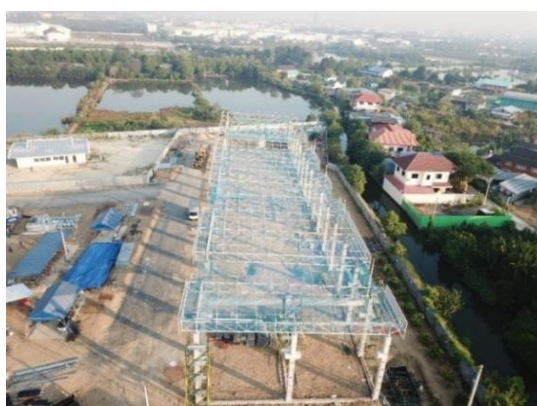
ภาพที่ 5 แสดงการยกโครงถักหลังคาแล้วเสร็จทั้งหมด
