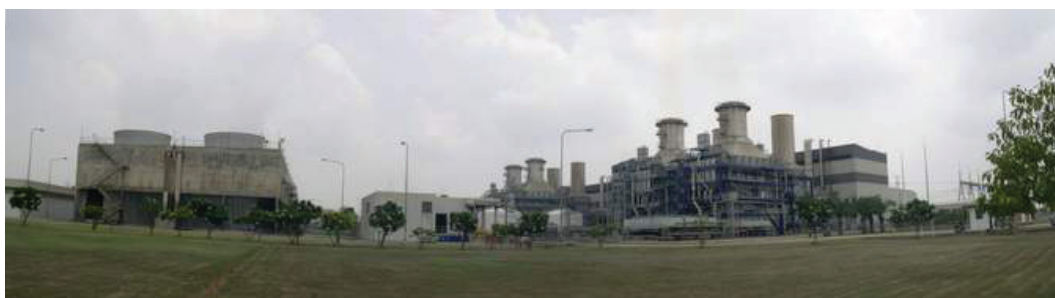
ภาพที่ 1: สิ่งก่อสร้างหลักของโรงไฟฟ้าวังน้อย
