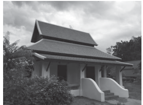
ภาพที่ 16: หลังคากุฏิหลังจากเปลี่ยนเป็นกระเบื้องดินเผา
