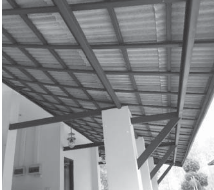
ภาพที่ 11: แสดงกระเบื้องลอนซึ่งภายหลังเปลี่ยนเป็นกระเบื้องดินเผา
