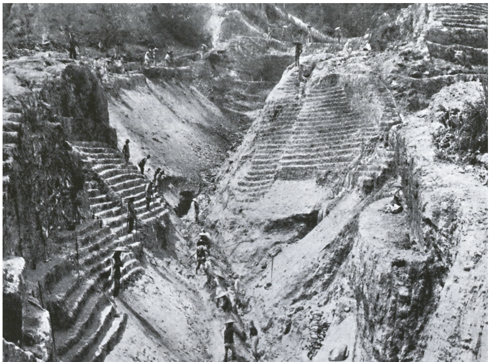
ภาพที่ 3: ลักษณะการทำเหมืองแบบเหมือนฉีดยาที่ใช้การฉีดน้ำในกระบวนการผลิตในหุบเขากินตา ที่มา: National Achieves Malaysia -2001/20025947 โครงการ The Economic History of Malaya Project.
