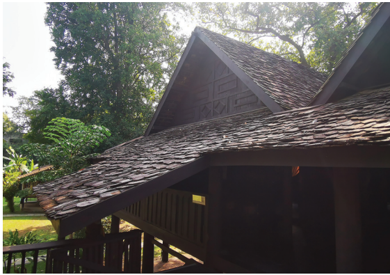
ภาพที่1: ไม้แป้นเกล็ดเรือนพื้นถิ่นภาคเหนือ กรณีศึกษา เรือนไทลื้อ (หม่อนตูด) ซึ่งปัจจุบันรื้อย้ายมาก่อสร้างใหม่ที่พิพิธภัณฑ์เรือนโบราณล้านนามหาวิทยาลัยเชียงใหม่
