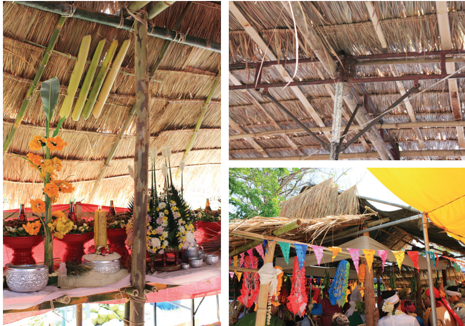
ภาพที่ 6: (ซ้าย) ผามที่ใช้เสาที่ทำจากไม้ยูคาลิปตัสแทนการใช้เสาไม้ไผ่แบบเดิม (ขวบน) การใช้ท่อเหล็กเสริมโครงสร้างหลังคา (ซ้ายล่าง) ผามที่ใช้โครงเตินท์เป็นโครงสร้างหลังคา
