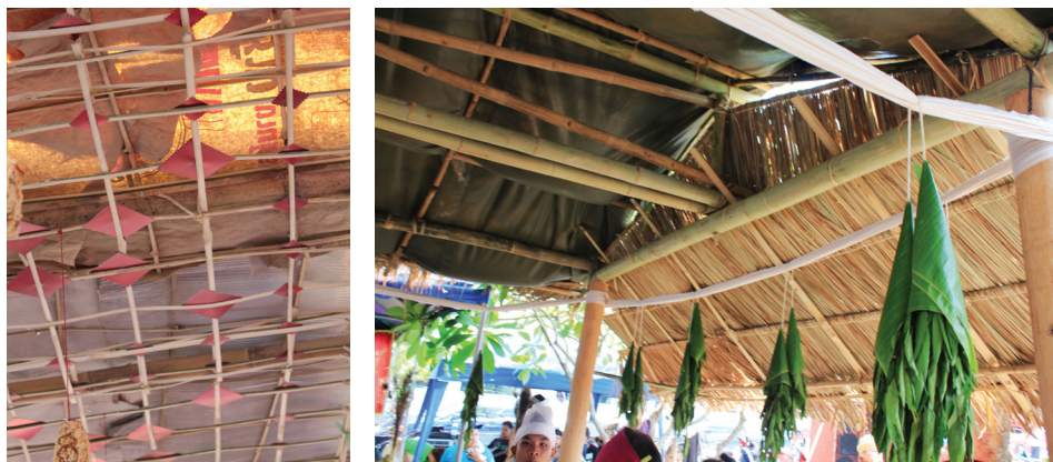
ภาพที่ 7: (ซ้าย) ผามที่ใช้กระดาษมาใช้เป็นวัสดุบุผนัง (ขวา) ผามที่ใช้ผ้าใบมาใช้เป็นวัสดุบุผนัง
