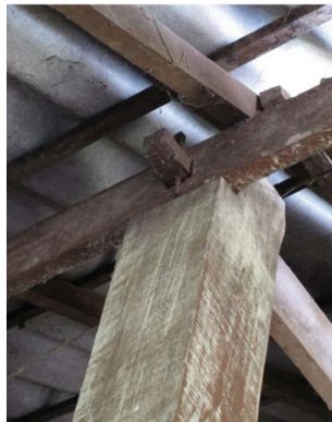
ภาพที่ 13: การบากหัวเสาโดย เลื่อยและยึดโดยสลักไม้
