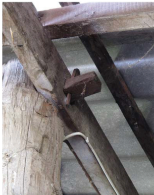
ภาพที่ 12: การบากหัวเสาโดย ขวานโดยสลักไม้
