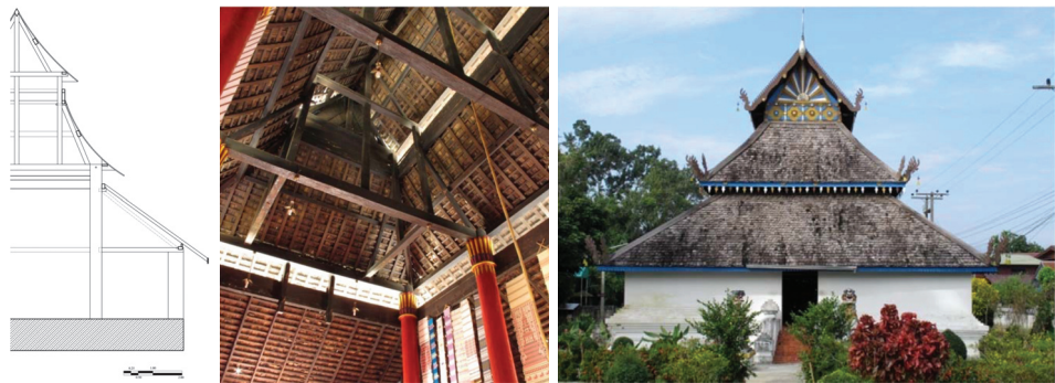
ภาพที่ 3: ภาพซ้าย แสดงแบบสถาปัตยกรรมแสดงรูปตัดวิหารวัดต้นแหลง, ภาพกลาง แสดงโครงสร้างหลังคา และภาพขวา แสดงรูปด้านสกัดของวิหาร
