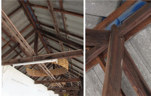
ภาพที่ 10: ภาพซ้ายแสดงโครงหลังคาศาลาบาตร และภาพขวาแสดง โครงตั้งโยแยกออกจากระนาบของดั่งอย่างชัดเจน
