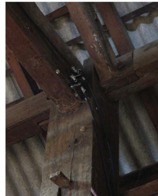
ภาพที่ 14: การบากหัวเสาด้วย เลื่อยและใช้ bolt ช่วยยึด
