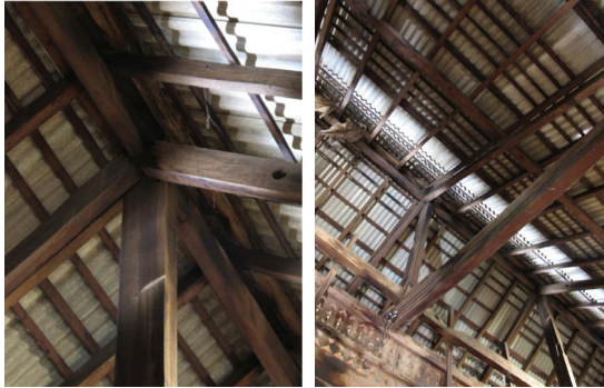
ภาพที่ 11: ภาพซ้าย แสดงโครงตั้งโยและ จันทัน และภาพขวาแสดงโครงตั้งโยและตั้ง
