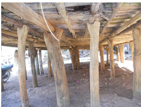
ภาพที่ 7: รายละเอียดเสาเรือนรับเสารเรือน
