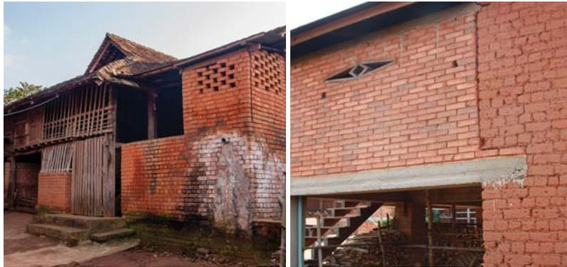
ภาพที่ 15: ลักษณะของช่องเปิดที่เกิดจากการก่ออิฐในรูปแบบใหม่
