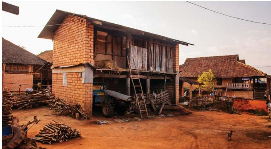
ภาพที่ 5: การใช้กำแพงอิฐรูปตัว U เป็นกำแพงรับน้ำหนัก ร่วมกับโครงสร้างไม้ ยังข้างจะเปิดออกทางด้านยาวที่เป็นโครงสร้างไม้เพียงด้านเดียว นอกจากจะขนย้ายข้าวได้สะดวกแล้ว ยังช่วยในการระบายอากาศอีกด้วย
