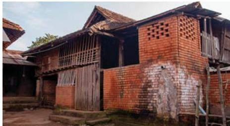
ภาพที่ 4: รูปแบบของเรือนไม้และอิฐในหมู่บ้านหนองบัว (บนซ้าย) เรือนที่ใช้กำแพงอิฐมาต่อเติมไม่เกี่ยวกับโครงสร้าง (บนขวา) เรือนที่ใช้กำแพงอิฐมาทดแทนโครงสร้างเดิม (ซ้าย) เรือนที่สร้างขึ้นด้วยอิฐทั้งหลัง
