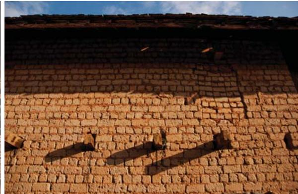
ภาพที่ 10: รายละเอียด (detail) ที่เกิดขึ้นจากการทำงานร่วมกันของไม้และอิฐ
