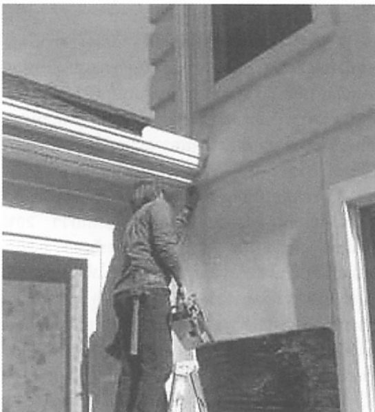
ภาพที่ 11 ตำแหน่งที่หลังคาชนกับผนังที่ไม่มี Flashing มักจะเป็นจุดพบปัญหาความชื้นซ่อนอยู่ข้างในผนัง (ที่มาภาพ: www.thehomeinspector.com )
