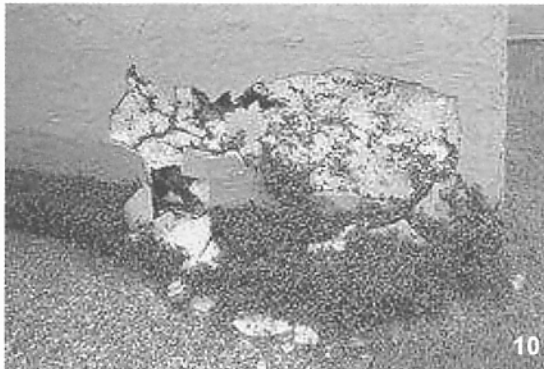
ภาพที่ 10 ผิวผนัง EIFS ซึ่งแตกลอกและอยู่ใกล้ระดับดิน ทำให้ความชื้นเข้าผนังได้ง่าย (ที่มาภาพ : www.ghiaa.net/09-eifs/09-eifs.htm )
