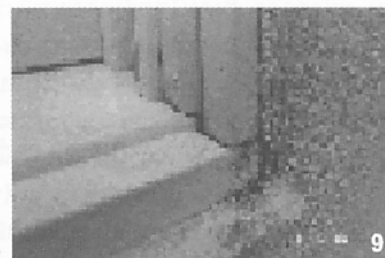
ภาพที่ 8-9 ตำแหน่งที่เจาะช่องหน้าต่าง จะเป็นจุดที่มักมีปัญหาความชื้น (ที่มาภาพ : www.gethomeinspector.com )
