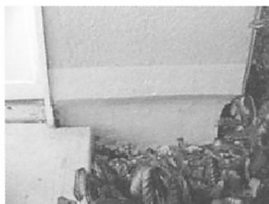
ภาพที่ 23 หลังตกแต่งผิวด้วยปูนสังเคราะห์และแต่งสีให้กลมกลืน
