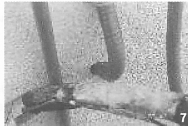
ภาพที่ 6-7 ตำแหน่งที่มีการเจาะรูผนัง EIFS ซึ่งเป็นจุดที่ความชื้นเข้าข้างใน (ที่มาภาพ : www.gethomeinspector.com )
