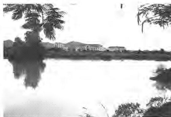
ภาพที่ 11 อาคารที่ก่อสร้างแล้วในมหาวิทยาลัยตามแนวความคิด พ.ศ.2544
