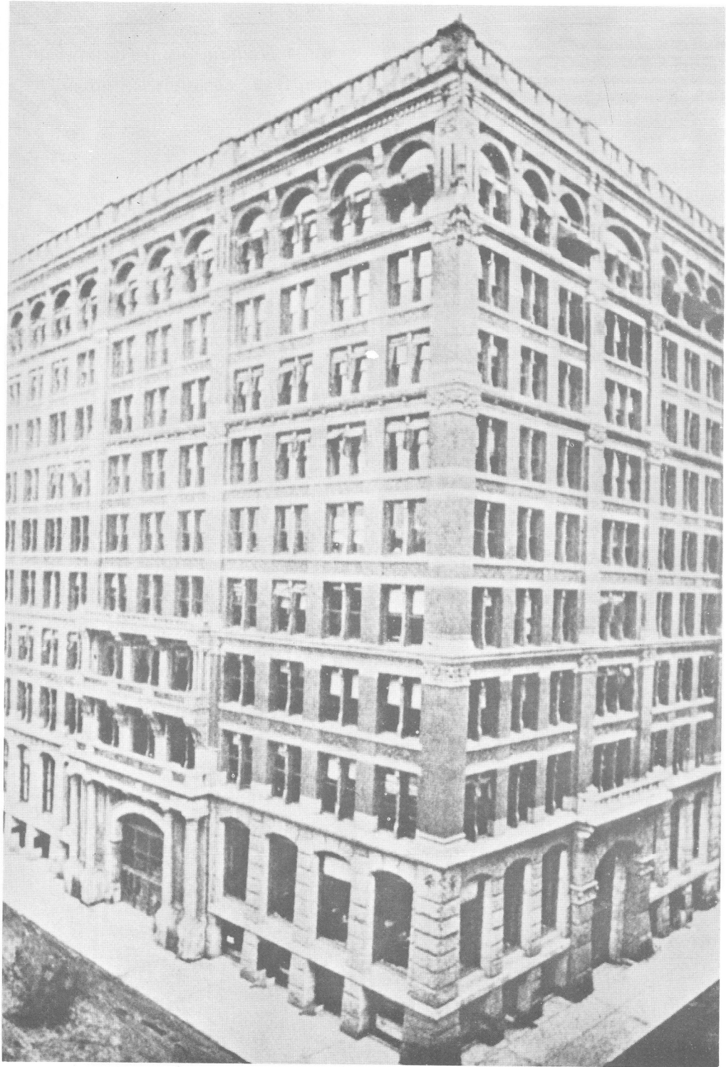
อาคาร Home Life Insurance Company ในนครชิคาโก ค.ศ. 1884-85 โดย William Le Baron Jenney เป็นตึกระฟ้าซึ่งใช้โครงอาคารเป็นเหล็กทั้งหมดครั้งแรก
