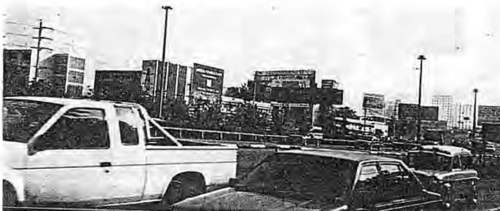
แฟลต BLOCK C และอาคารบางส่วนใน BLOCK A (จาก ถ. วิภาวดีฯ)
