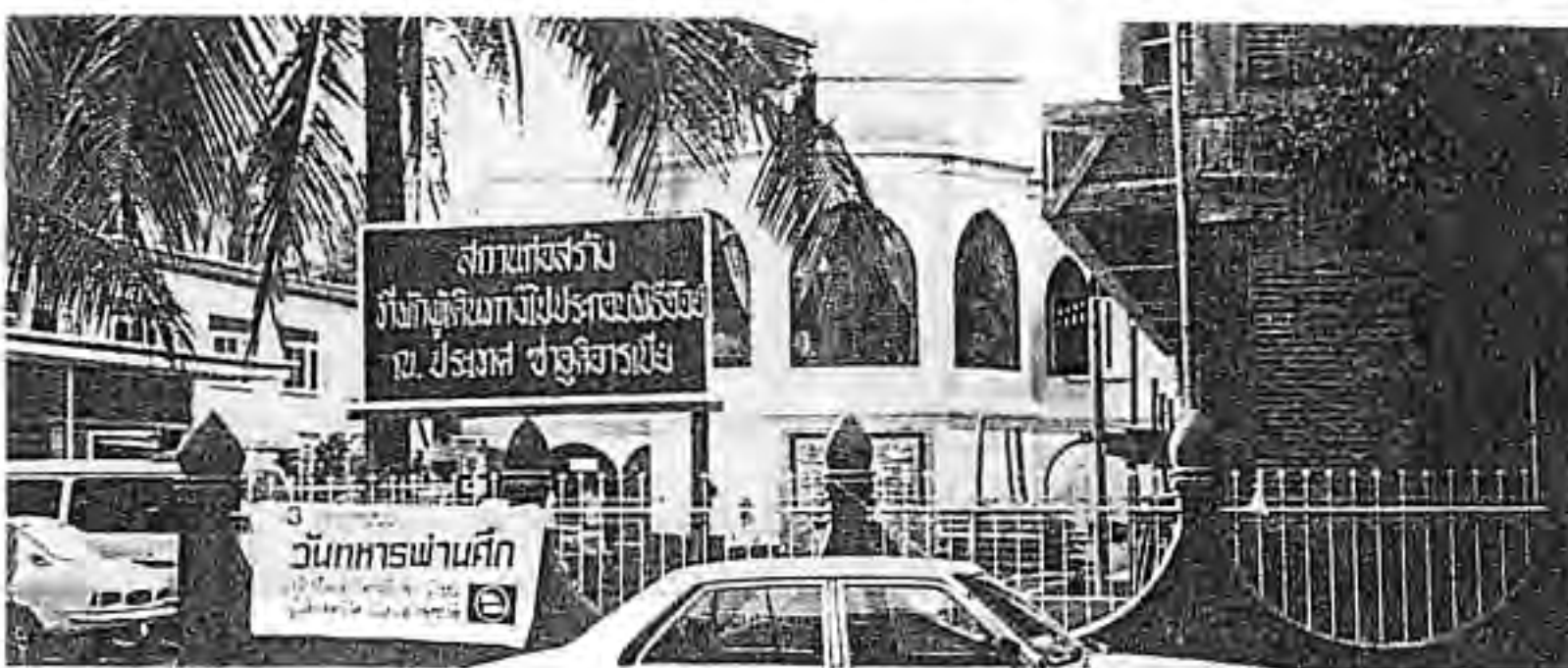
มัลลียัดข้าง BLOCK A ( จาก ถ.มิตรไมตรี)
