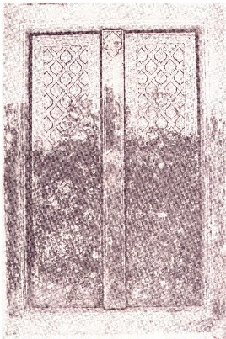
บานประตูทางเข้าภายในองค์พระเจดีย์ ใช้เป็นบานเปิด 2 บาน มีอกเสา กรอบขีดหน้าแบบอย่างประเพณี ตัวบานลงรักปิดทอง
