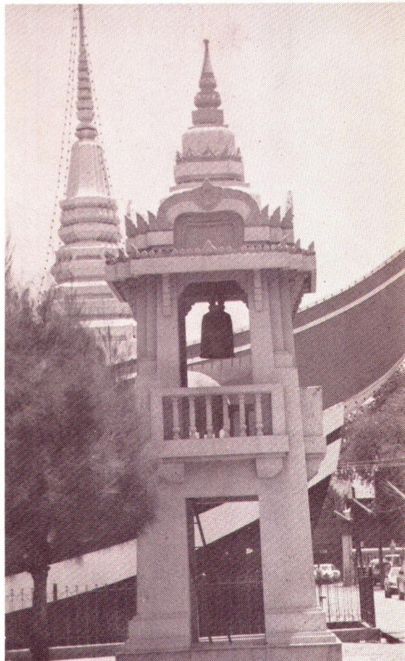
เป็นหอระฆังสูง 2 ชั้น สร้างด้วยคอนกรีตเสริมเหล็ก ส่วนยอดต่อเป็นชั้นหลังคาขึ้นไป การประดับตกแต่งลาย ให้ความสำคัญที่ส่วนยอดนี้โดยเฉพาะ
