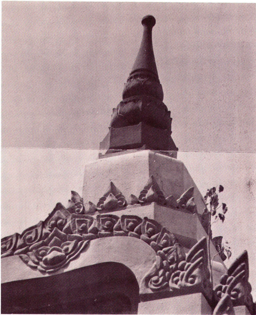
กรอบบันแถลง ใช้แบบกรอบหน้านาง ตรงกลางทำเป็นตัวหน้าขบ
