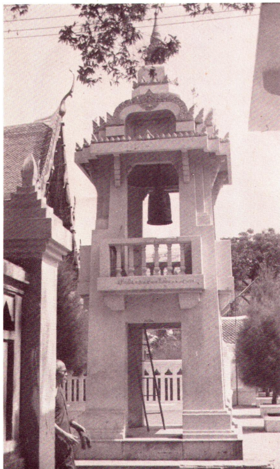
เป็นหอระฆังสูง 2 ชั้น สร้างด้วยคอนกรีตเสริมเหล็ก ส่วนยอดต่อเป็นชั้นหลังคาขึ้นไป การประดับตกแต่งลาย ให้ความสำคัญที่ส่วนยอดนี้โดยเฉพาะ
