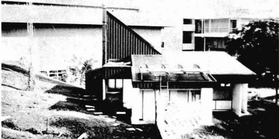
รูปที่ 43 หลังคาแบบทางด้านซ้ายคือที่เก็บน้ำเหนือห้องนอน หลังคาทางด้านหน้าติดตั้งเครื่องรับพลังงานแสงอาทิตย์ที่ปรับมุมได้ ส่วนหลังคาทางด้านหลังติดตั้งเครื่องรับที่ติดตั้งเป็นแผ่นเรียบ เอียงตามแนวหลังคา
