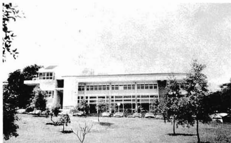
รูปที่ 6 ศูนย์คอมพิวเตอร์
