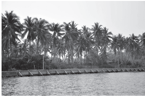
ภาพที่ 32: เขื่อนคอนกรีตที่สร้างเสร็จแล้ว
