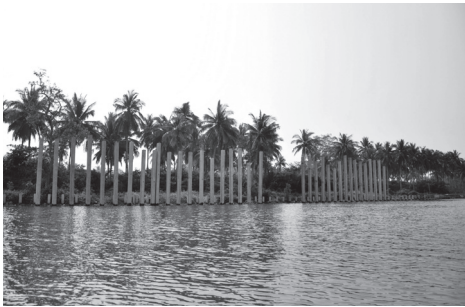
ภาพที่ 31: กำลังดอกเส้าเข็มเพื่อสร้างเขื่อนคอนกรีต
