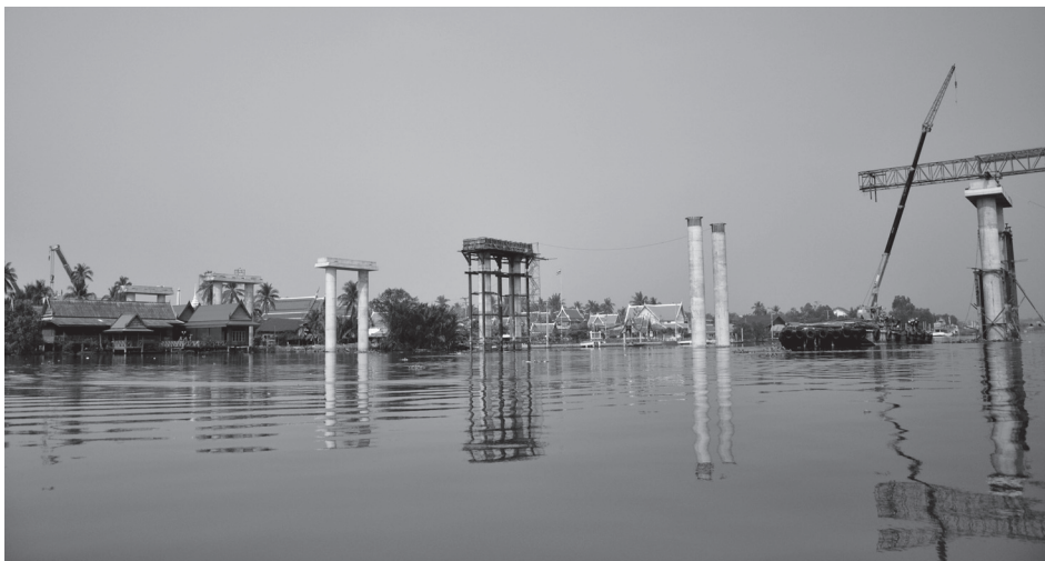
ภาพที่ 24: การก่อสร้างสะพานข้ามแม่น้ำขนาดใหญ่
