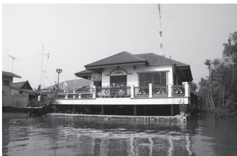
ภาพที่ 20: เรือนสมัยใหม่ที่มีการสร้างยกพื้นสูงเพื่อให้พ้นระดับน้ำขึ้นสูงสุด และมีเขื่อนคอนกรีตไว้กันคลื่น
