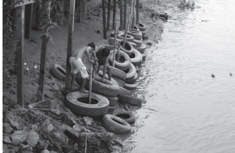
ภาพที่ 30: การต่อสู้การกัดเซาะของกระแสน้ำด้วยการใช้ภูมิปัญญาท้องถิ่นของชาวบ้านที่ดั่งบ้านเรือนอยู่ริมแม่น้ำ
