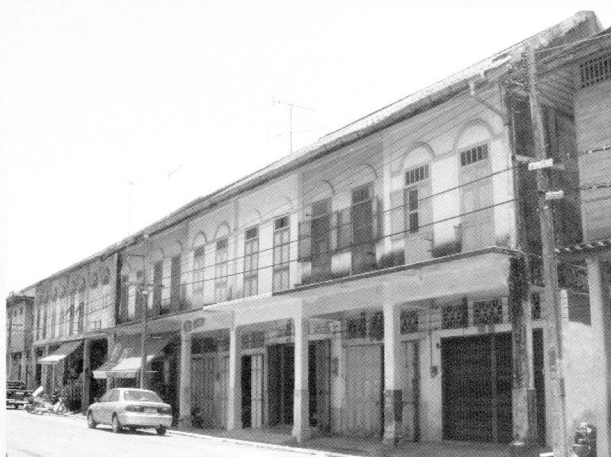
ภาพแสดงลักษณะอาคารรูปแบบชิโน-ยูโรเปียน บนถนนญาติ
