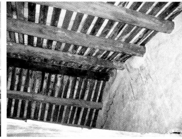
โครงสร้างหลังคา ตัวหลัก
