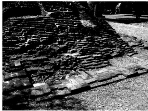
ภาพที่ 4 : การก่อฐานรากแบบผังตาราง ก่อนที่จะใช้อิฐก่อปิดช่องว่างขึ้นเป็นองค์พระเจดีย์
