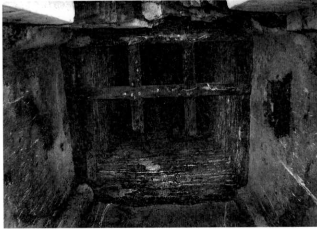
ภาพที่ 9 : โครงสร้างไม้ ภายในพระเจดีย์ประธาน ทรงปราสาท วัดโลกยสุทธา
