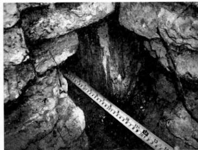
ภาพที่ 11 : การตั้งเสาไม้ โครงสร้างที่มุมทั้งสี่ภายในเรือน ธาตุพระเจดีย์ก่อนที่จะก่ออิฐ หุ้มปิดขึ้นเป็นองค์พระเจดีย์
