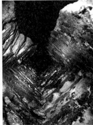
ภาพที่ 10 : ร่องรอยการตั้งเสาไม้ ขนาดใหญ่ภายในพระเจดีย์ประธาน ทรงปราสาท วัดไชยวัฒนารามเพื่อ ก่อขึ้นเป็นโครงสร้างส่วนยอด ก่อน ที่จะก่ออิฐขึ้นเป็นองค์พระเจดีย์
