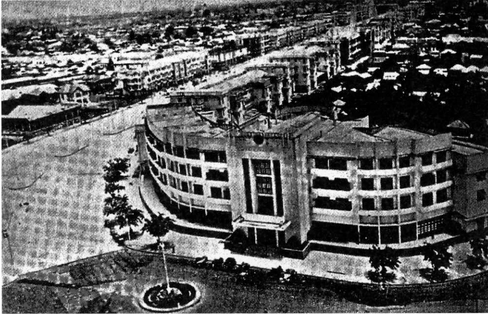
ภาพที่ 2 : อาคารสองฝั่งถนนราชดำเนินกลาง (พ.ศ. 2483-2485) เป็นโครงการขนาดใหญ่ประกอบไปด้วย อาคารพาณิชย์ สถานที่ราชการ และโรงแรม โดยมีรูปแบบทางสถาปัตยกรรมแบบ “ทันสมัย” ในสายตาของรัฐบาลในสมัยนั้น
