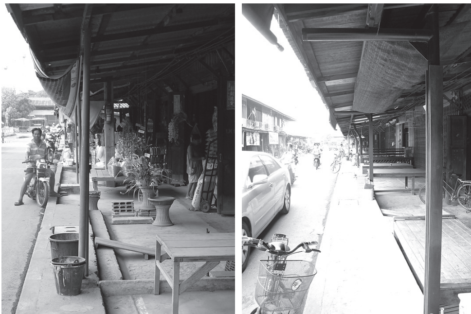
แนวเสารับขายคาก่อนการปรับปรุง
