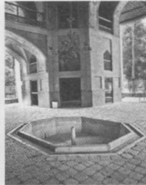
ภาพที่ 51 : บ่อน้ำพุ 8 เหลี่ยมกลางสระกรุด้วยหินอ่อน มีท่อสำหรับส่งน้ำพุตรงกลาง (ภาพซ้าย) บ่อน้ำพุตั้งอยู่กลางแผนผังที่พระตำหนักฮัซซเบซท์ (ภาพขวา)
