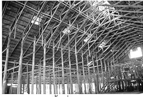
พื้นที่โถงหลักโถงสูง
