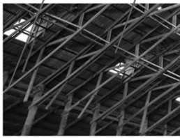
แปะยึดหัวเสา แปะยึดระหว่างโครงถัก ค้ำยันแนวทแยง ค้ำยันแนวตั้ง ช่องแสงมีหลังคาจั่วขนาดเล็ก (ดอร์เมอร์) การประกอบไม้รับค้ำยันแนวตั้ง
