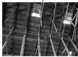
แปะยึดหัวเสา แปะยึดระหว่างโครงถัก ค้ำยันแนวทแยง ค้ำยันแนวตั้ง ช่องแสงมีหลังคาจั่วขนาดเล็ก (ดอร์เมอร์) การประกอบไม้รับค้ำยันแนวตั้ง
