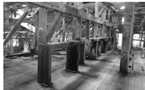
ตำแหน่งติดตั้งอุปกรณ์บนพื้นยก จุดติดตั้งเครื่องกะเทาะและเครื่องขัดข้าว
