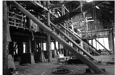
ไม้ค้ำยันโครงสร้างโรงสี
