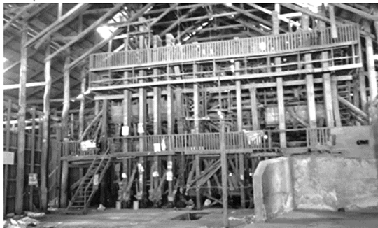
ร้านโรงสีเพื่อติดตั้งอุปกรณ์สีข้าวก่อนรื้อ
