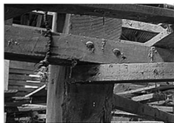
หัวนอตยึดเสากับโครงสร้างร้านโรงสี
