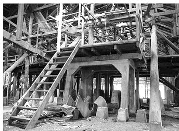
ฐานเสา คสล. รับร้านโรงสี
