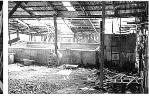
หลังคาพาไลด้านหลัง
