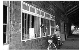
ห้องสำหรับติดต่อสำนักงาน
