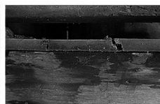
การเข้าลิ้นพื้นไม้เรือนพักอาศัย
