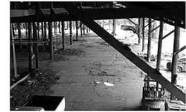
มุมมองจากระเบียงชั้นบนมองไปโรงทางเข้า
