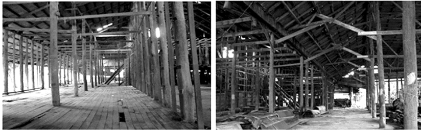
แสดงโครงสร้างหลังคาส่วนเก็บข้าวสาร (ซ้าย) และหลังคาส่วนเก็บข้าวเปลือก (ขวา)
