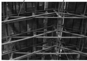
แปะยึดหัวเสา แปะยึดระหว่างโครงถัก ค้ำยันแนวทแยง ค้ำยันแนวตั้ง ช่องแสงมีหลังคาจั่วขนาดเล็ก (ดอร์เมอร์) การประกอบไม้รับค้ำยันแนวตั้ง
