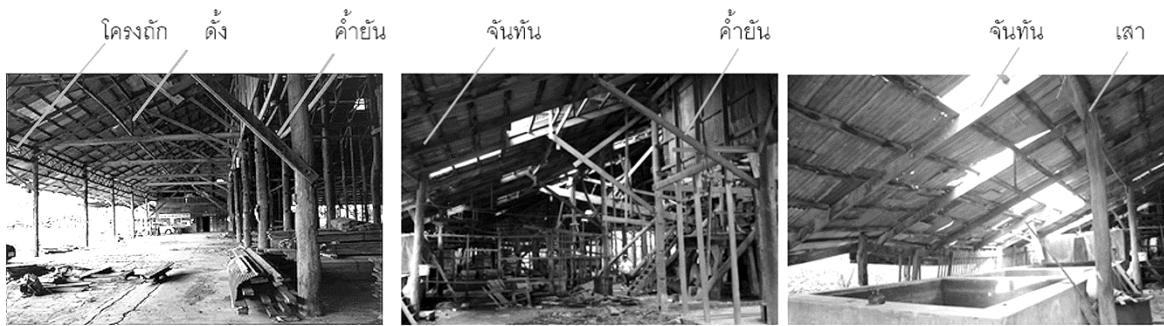
แสดงโครงสร้างหลังคาพาไลด้านหน้า (ซ้าย) และหลังคาพาไลด้านหลัง (2 รูปขวา)
