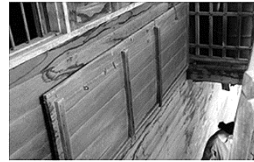
ประตูปิดบันไดทางขึ้นห้องพักชั้นบน
