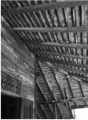
รายละเอียดหลังคาและ ลักษณะการมุงกระเบื้อง ดินขอ
