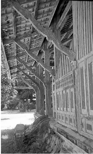
บนและล่าง: การเปลี่ยนระดับโครงสร้างพื้นโดยรอบที่ต่ำกว่าพื้นที่กลางอาคารของอุโบสถไม้ วัดน้ำขาวใน
