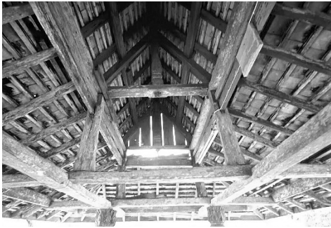
บนและขวา: เสาดักดาชุดหลังคากลางตั้งอยู่ บนช่อหลัก (ศาลาโถงวัดหงษาราม)
