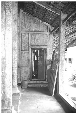
บริเวณตอนบนของอุโบสถไม้ วัดน้ำขาวใน มีลักษณะ โครงสร้างแบบอะเสสองชั้น
