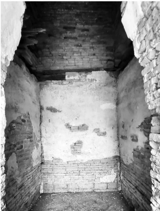
ตัวอย่างหลักฐานด้านเทคนิคการก่อสร้างเจดีย์รายองค์ทิศเหนือข้างอุโบสถ วัดมหาธาตุ
