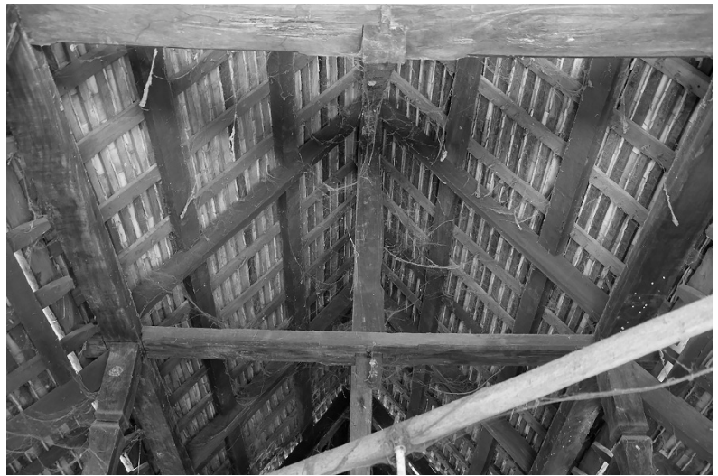
ภาพที่ 7: โครงสร้างหลังคามัสยิดอาโฮ
