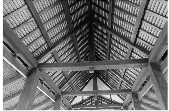
ภาพที่ 9: โครงสร้างหลังคามัสยิดนัจมุดดิน
