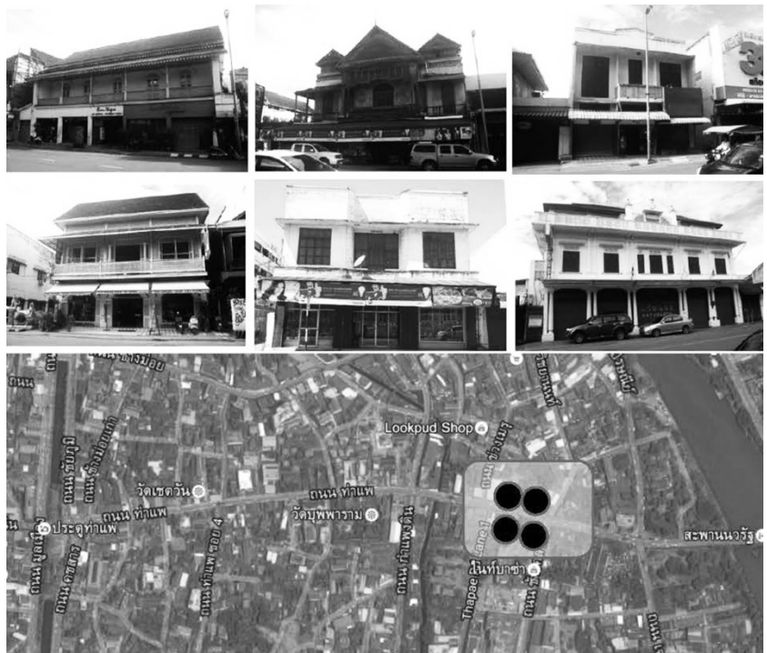
ภาพที่ 12 ตึกแถวลักษณะต่าง ๆ ที่เรียงรายกันอยู่บนถนนท่าแพ ฝั่งหัวถนนท่าแพ (บริเวณระหว่างถนนช้างคลานถึงถนนช่วงเมรุ) คาดว่าน่าจะสร้างตั้งแต่ในช่วง พ.ศ. 2480-2500
