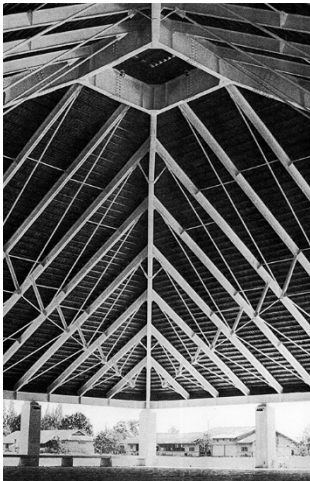
ซ้าย : ภาพที่ 22 โครงสร้าง หลังคาเหล็กรับแรงดึง
