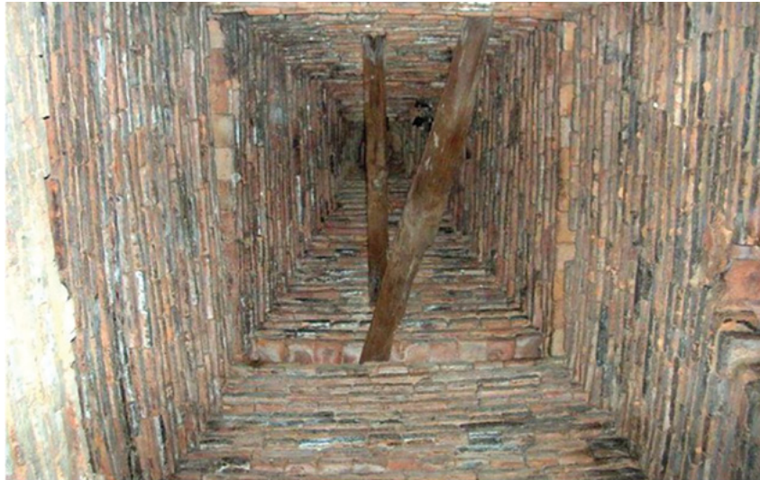
ภาพ 7 ผังโครงสร้างภายในของ เจดีย์ประธานองค์ใหม่ ที่ก่อครอบเจดีย์องค์เดิม วัดจงกลม
