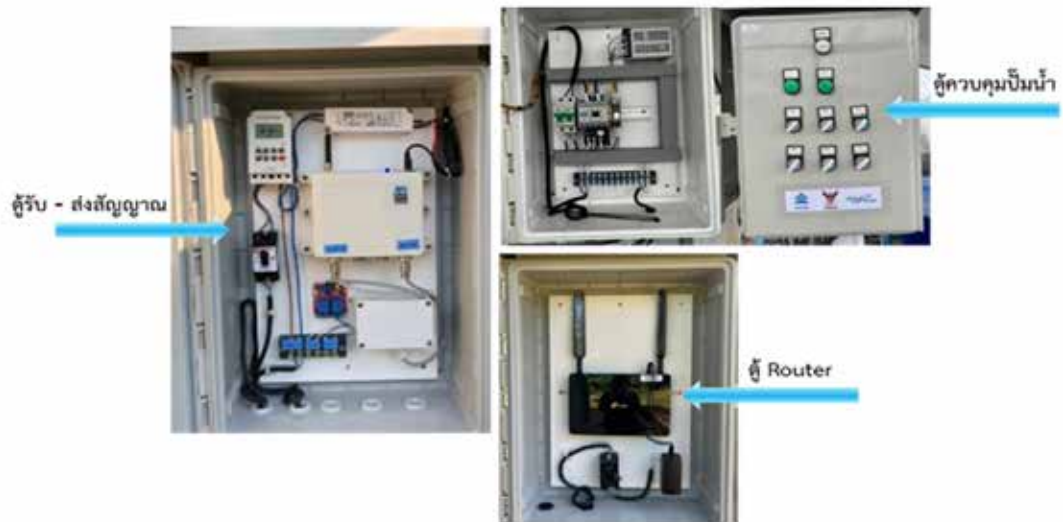
ภาพที่ 3 ตู้รับ-ส่งสัญญาณ อุปกรณ์ตู้ควบคุมปั้มน้ำ และตู้ router
