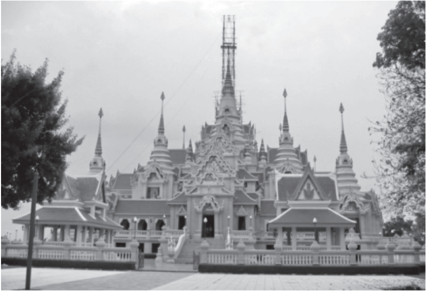
รูปที่ ๓๗ พระมหาธาตุเจดีย์ภักดีประกาศ จังหวัดประจวบคีรีขันธ์ ผนวกอาคารเจดีย์ อุโบสถ วิหาร และระบียงคต ไว้ในอาคารหลังเดียว
