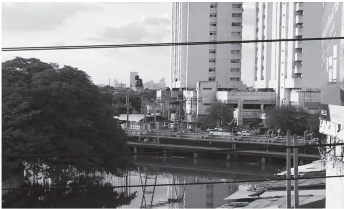
ภาพที่ ๔ ประตูปะบายน้ำกั้นเส้นทางคลองสำโรงทำให้ไม่สามารถใช้เส้นทางเดินเรือ จากบางบ่อ บางพลี ไปออกแม่น้ำเจ้าพระยาเช่นในอดีต บันทึกภาพเมื่อวันที่ ๒๑ มกราคม ๒๕๖๑
