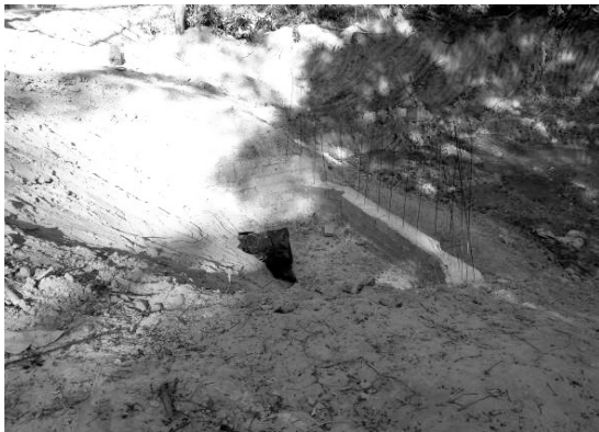
รูปที่ 7 ฝายที่หลงพอเยื้องสร้างจะมีลักษณะที่เรียกว่าฝายชะลอน้ำแบบคอนกรีตเสริมเหล็ก ที่มา: ผู้วิจัย (2559)
