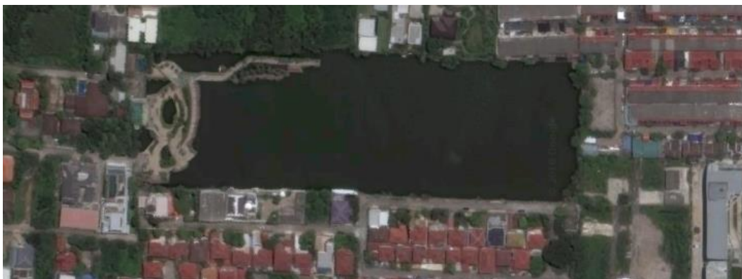
รูปที่ 17 ภาพถ่ายทางอากาศแสดงโครงการเมื่อก่อสร้างระยะที่ 1 แล้วเสร็จ ที่มา: ผู้วิจัย (2552)
