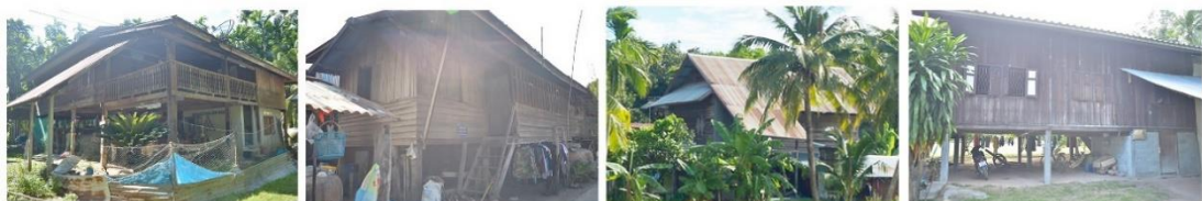
2. รูปแบบเรือนพื้นถิ่นประยุกต์ ปลูกสร้างมาแล้วราว 50-70 ปี มีการประยุกต์ใช้รูปแบบดั้งเดิม (ในแบบแรก) ทั้งรูปทรงหรือแบบแผนการใช้งาน คือ ยังมีชานของเรือน มีการใช้ใต้ถุน ปลูกสร้างด้วยไม้ (ปัจจุบันมีการปรับปรุงด้วยวัสดุใหม่)
