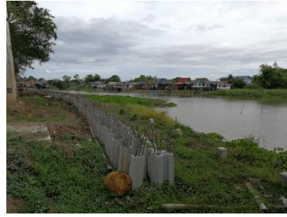
รูปที่ 3 การตอกเสาเข็มทำโครงสร้างป้องกันตลิ่งทรุด ริมคลองรางจระเข้
