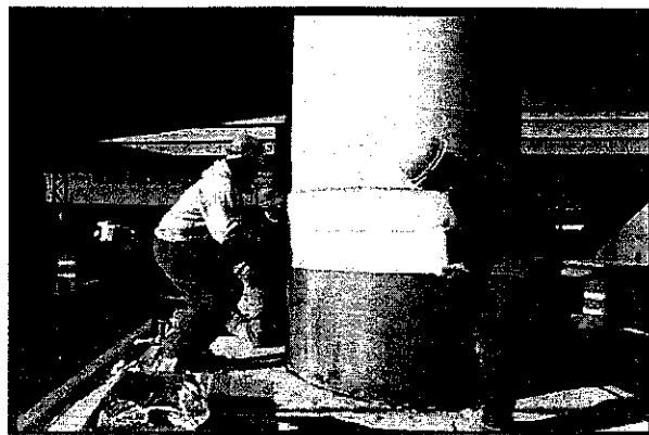
รูปที่ 2 ลักษณะการดำเนินการหุ้มผิวของเสาตอม่อของอาคารขนาดใหญ่ 2 (Aqua Wraps 22-77 operation 2)
