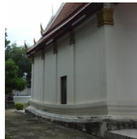
ฐานटकทองสำเภา งานสถาปัตยกรรมอยุธยา
