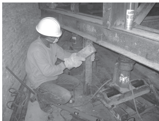
รูปที่ 19 ภาพแสดงการเปลี่ยนถ่ายแม่แรงเหล็ก 30 ตัน 4 ตัว ซึ่งแต่ละตัวได้เชื่อมกับเสาเหล็ก และขึ้นแม่แรงอีก 30 ตันสำรองอีก 2 ตัว ค้ำยันก่อนแต่ยังคงค้างแม่แรงไฮดรอลิก 50 ตัน 2 ตัวไว้ก่อนจนกว่าจะทำการเปลี่ยนถ่ายแม่แรงอีกทั้ง 4 ตัวเสร็จสิ้น
