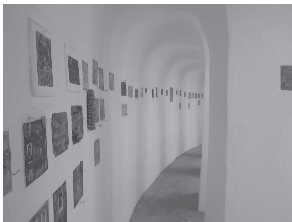
รูปที่ 5 สภาพพระเบียงคตชั้นล่างรอบองค์พระเจดีย์ ก่อนทำการบูรณะ มีการเจาะใส่ที่บรรจุอัฐิจำนวนมาก ไม่เป็นระเบียบและรูปแบบมีหลากหลาย ไม่มีไฟแสงสว่าง
