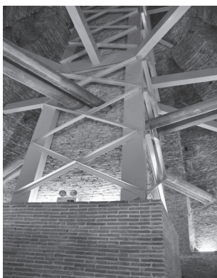
รูปที่ 18 ภาพหลังการบูรณะแล้วเสร็จ แสดงบรรยากาศการจัดแสงในส่วนเสาแกนกลาง แสดงให้เห็นโครงเหล็กยึดป้องกันเสาอิฐเดิม พร้อมติดตั้งตัวอย่างไม้ซุงตามตำแหน่งรูไม้ซุงของเดิม
