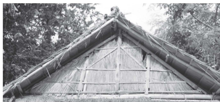
รูปที่ 14 ลักษณะการเข้าไม้ในส่วนหลังคาเรือนญ้อ
