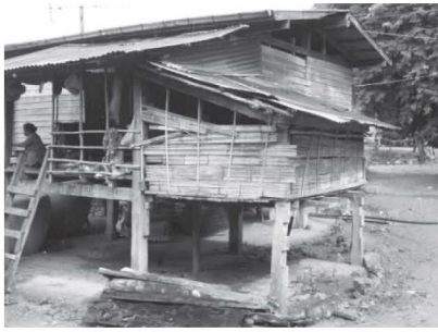
รูปที่ 8 ฝาฟากสับส่วนครัว เรือนนางแต้ว น้อยเสลา ที่มา: รวบรวมข้อมูลโดยผู้วิจัย
