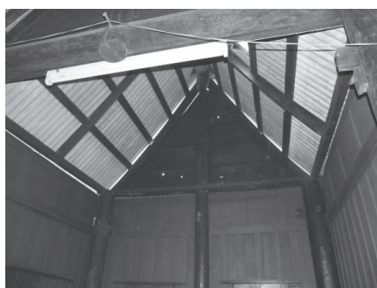
รูปที่ 11 แสดงรูปการใช้วัสดุประเภทกระเบื้องลอนคู่แทนวัสดุประเภทเดิมเช่นกระเบื้องหางว่าว ใบจาก ส่งผลให้องค์ประกอบของหลังคาหายไปได้แก่ กลอน และระแนง
