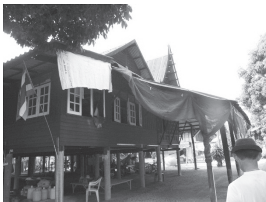
รูปที่ 6 แสดงรูปเรือนไทยประยุกต์ ที่มีการนำเรือนไทยเดิม มาปรุ้งใหม่ร่วมกับโครงสร้างประยุกต์ ในภาพใช้เสาปูนแทนเสาเดิม ที่มา: ผู้วิจัยเป็นผู้ถ่าย
