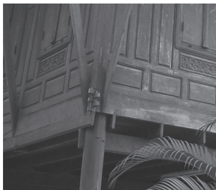
รูปที่ 8 แสดงรูปโครงสร้างรับพื้นแบบรอตรับตง ที่มา: ผู้วิจัยเป็นผู้ถ่าย
