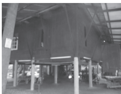
รูปที่ 10 แสดงรูปการใช้เสา ค.ส.ล. แทนเสาไม้ในส่วนเดี่ยวล่าง ที่มา: ผู้วิจัยเป็นผู้ถ่าย
