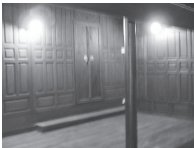
รูปที่ 4 แสดงรูปการประยุกต์ฝ้าเรือนโดยการเพิ่มระบบงานไฟส่องสว่าง และปรับซ่อนระบบไฟฟ้าไว้ภายในฝ้าผนังเรือน
