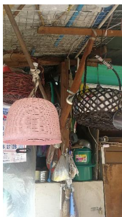
รูปที่ 11 โครงสร้าง บริเวณวิจัยที่ 2
