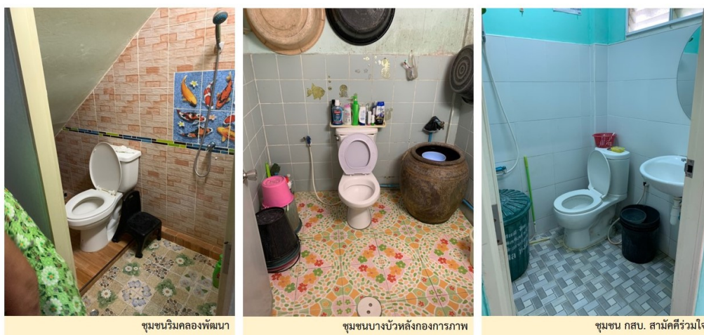
รูปที่ 5 ตัวอย่างปัญหาของห้องน้ำในเรือนาคัด วัสดุพื้นผิวมีความลื่น และการขาดอุปกรณ์ยึดเกาะพุงตัว
