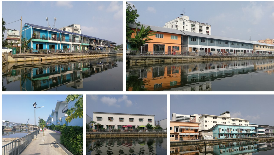
รูปที่ 2 ตัวอย่างชุมชนริมคลองลาดพร้าวที่ได้รับการปรับปรุงตามแนวทางโครงการบ้านมั่นคง
