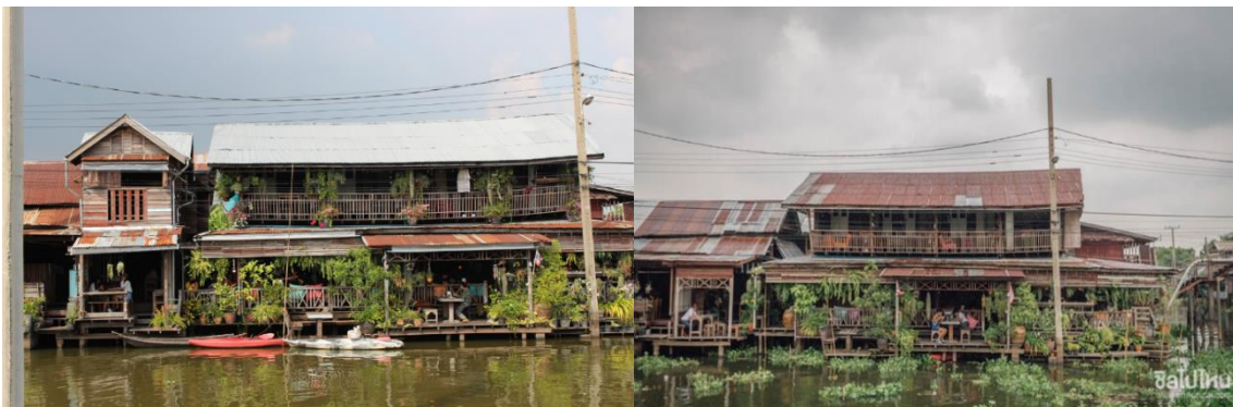
รูปที่ 6 กรณีศึกษาของการปรับปรุงซ่อมแซมอาคารในรูปแบบเดิม (ร้านสี่แยกหัวตะเข้ Café & Guesthouse)
